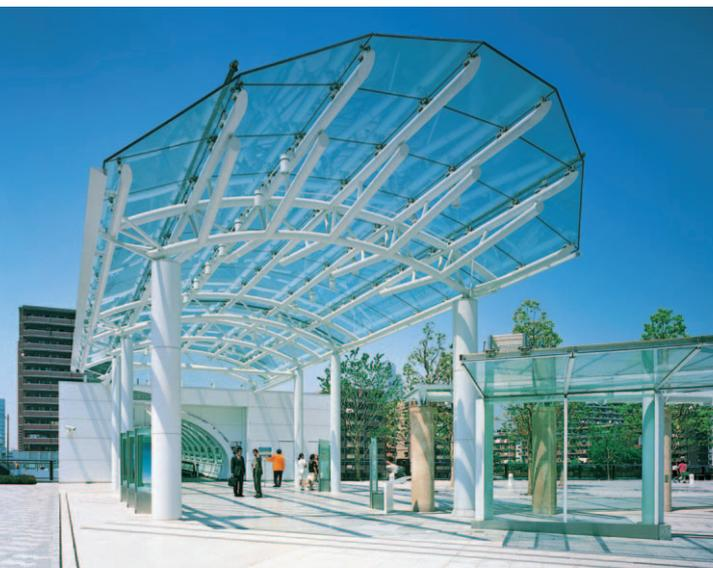
動く歩道のキャノピーは、DPG構法によるガラスを、下からスチールトラスで支えている
