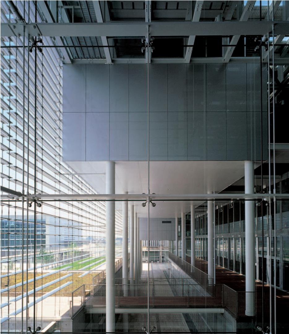
3層吹き抜けのオープンスペースは、外側に日射調整用のルーバーが取り付けられており、柔らかな自然光が差し込む空間になっている。ルーバーによって強調される横のラインと合わせて、内部に立ち上がるガラスの支持構造体も、横のラインを描く手法をとった。
