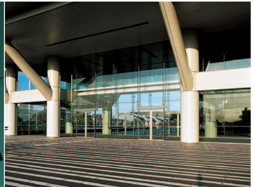
支持構造体としてのリブガラスをダブルで用いている(写真左)。DPG構法とリブガラス(ハーフ)の組み合わせが、透明感の高いエントランスを創り出した
