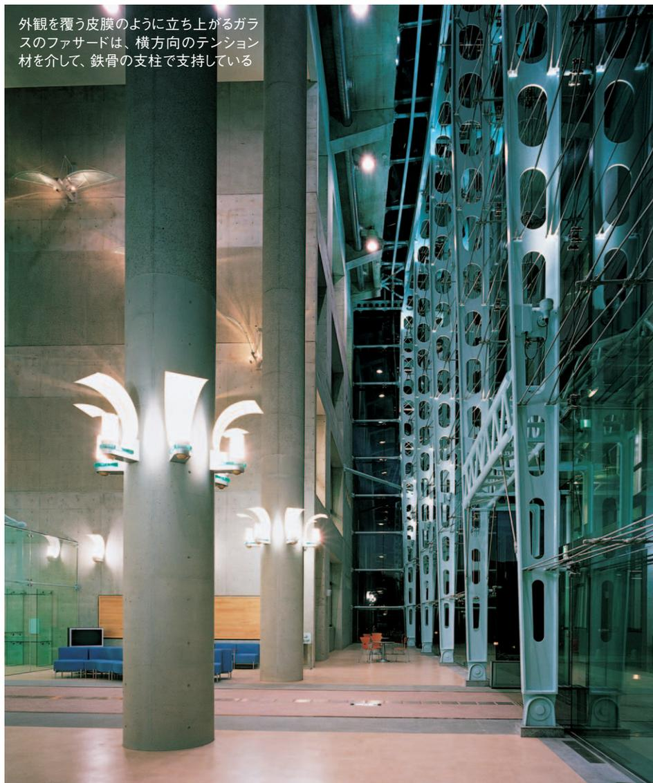
外観を覆う皮膜のように立ち上がるガラスのファサードは、横方向のテンション材を介して、鉄骨の支柱で支持している
