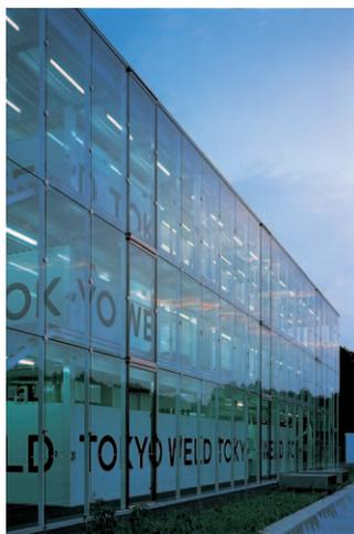
EPG構法によって、透視性の高いガラスの壁面を創り出した(写真左)。ガラスはピース金物と縦型のスチールマリオンで支持している
