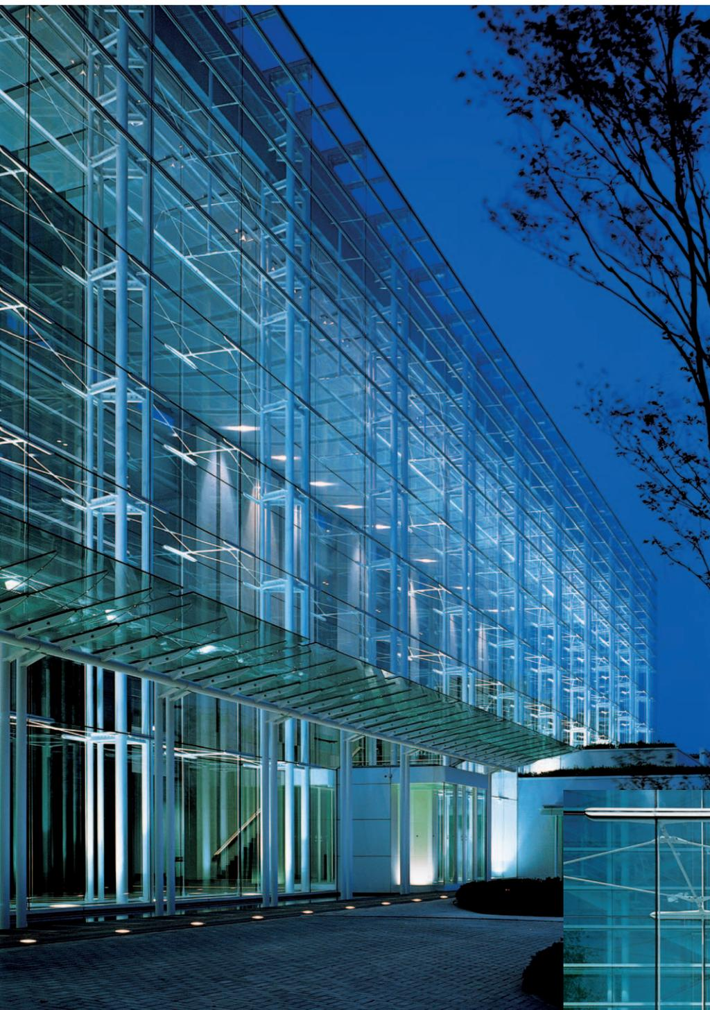
ガラスのカーテンウォールの内部には、建築の構造体でもある3本の組み柱で大スパンを実現した開放的な空間が広がる。組み柱のスパン割りと合わせたことから、ダブルスキンのカーテンウォールを構成する面ガラスは横長の割り付けになり、2枚ごとに組み柱に支持する必要があった。
